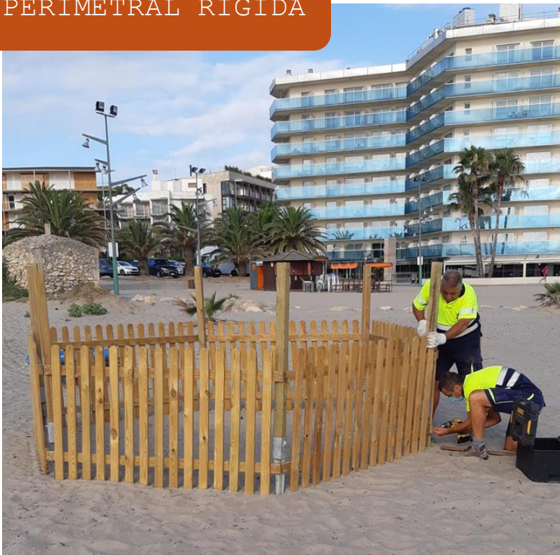
ESTRUCTURA PERIMETRAL RÍGIDA
